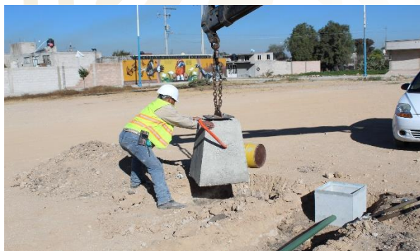
Trabajos realizados para la colocación de luminarias en el estacionamiento
