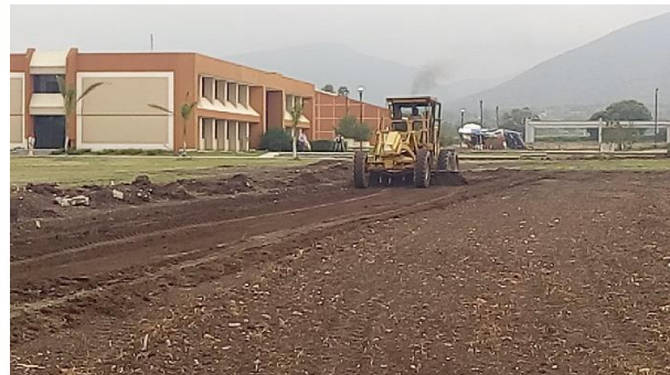
Ejecución de actividades para la habilitación del campo de futbol
