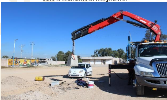
Inicio de instalación de luminarias ubicadas en el estacionamiento
