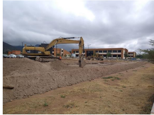
Inicio de Construcción del estacionamiento 1ª etapa
