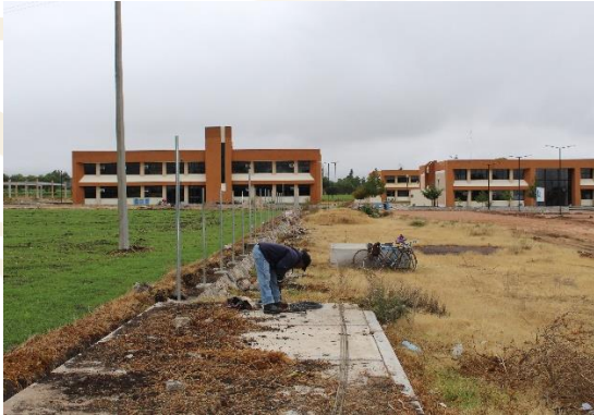
Inicio de construcción del cerco perimetral
